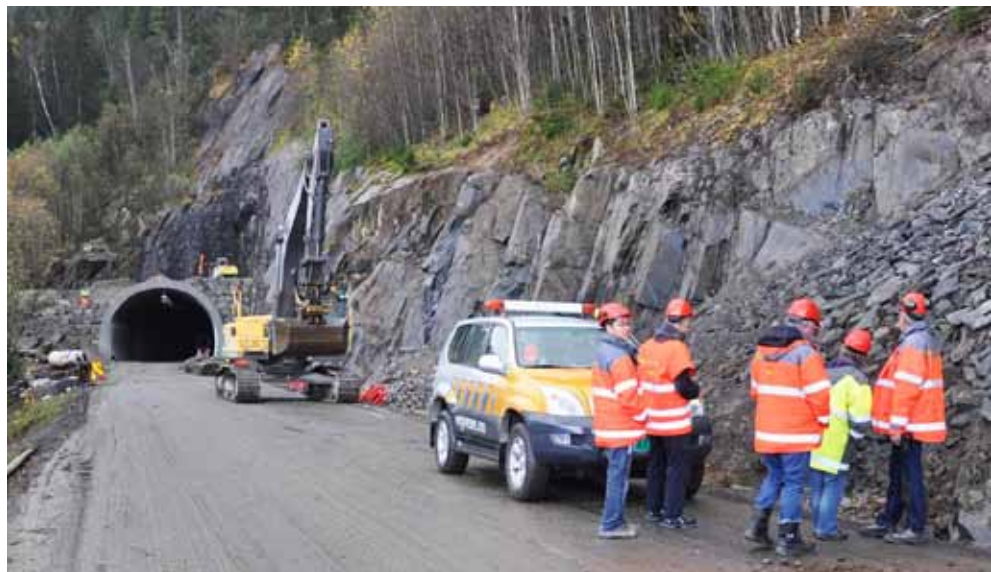
Tunnelene Jønjljo (760 meter) og Prestura (1380 meter) på Tinnsjøvegen fylkesvei 37 ble rehabilitert i 2011. Foto: Statens vegvesen
