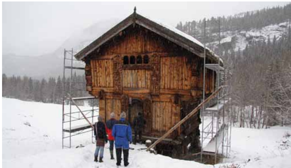
Befaring våren 2011 i forbindelse med takomlegging på vedtaksfredet loft i Seljord. Foto: Gunnhild Randen
