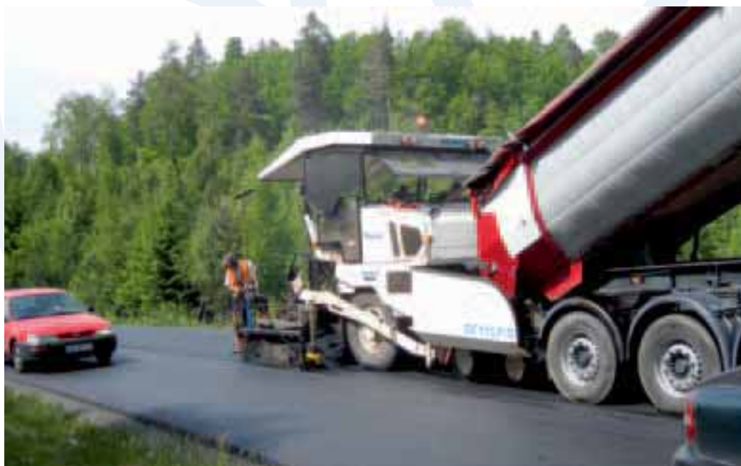
Asfaltering på Rv 351 Kjolebrønd-Tangen. Det ble asfaltert 79 km fylkesveier og 5 km G/S-veier i 2010. (Foto: Statens vegvesen)
