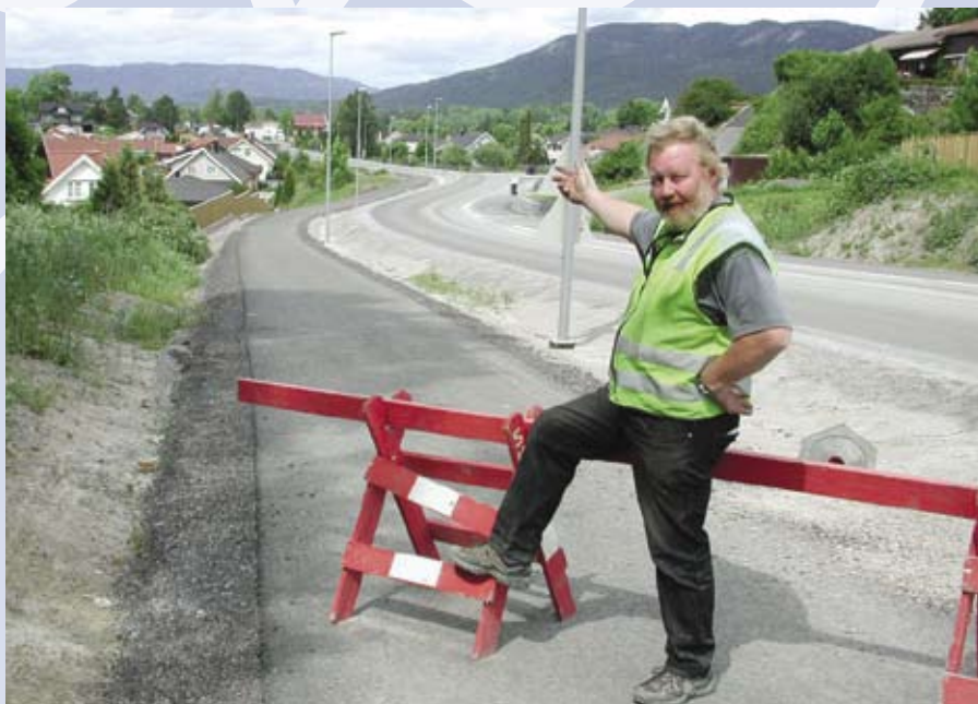
Anleggsbas Finn Cato Torgersen viser fram den ferdige GS-veien og den nyasfalterte Luksefjellveien i Skien. Anlegget har kostet 12,8 mill. kroner og var ferdig høsten 2007.
